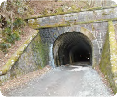
旧天城トンネル
