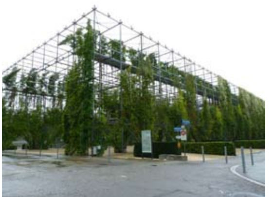
つる植物で囲われたチューリヒの立体緑地公園 MFO パークは、奥行100m×幅35m×高さ17mの鋼鉄製の建物による「まさしく立体公園」である
