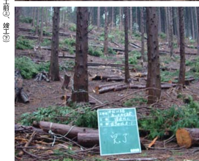
作業状況(着工前)①、竣工②
